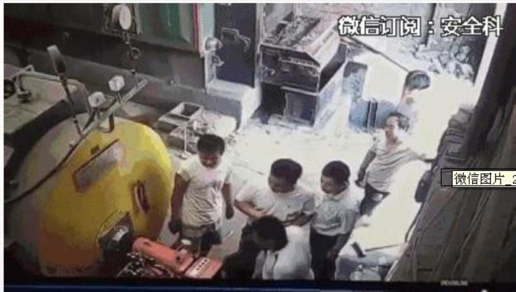
**事故原因：**操作人员违章操作，在近一小时时间内连续点火21次，导致炉膛内可燃气体体积聚过多，第22次点火时发生爆炸。
