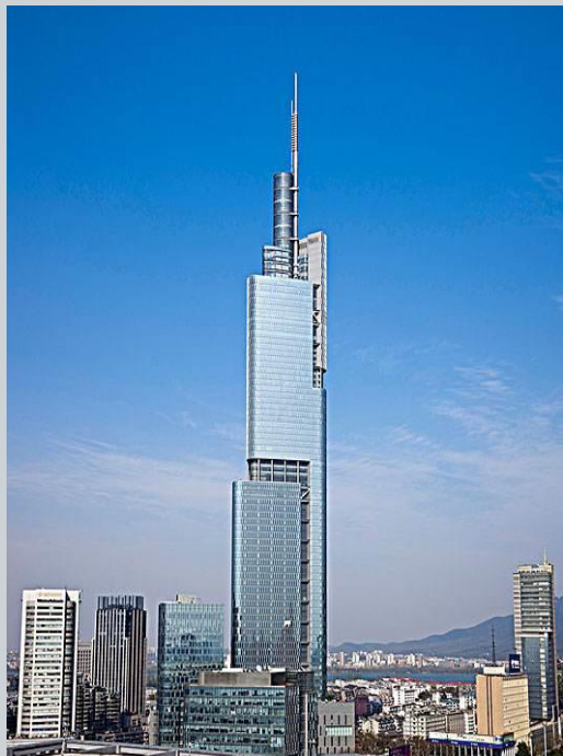
紫峰大厦，速度最快、提升高度最高的乘客电梯
